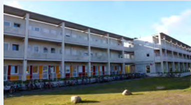
Wohnanlage „Am Schützenplatz“, vorderseitige Ansicht mit Eingang zur Beratungsstelle (© Beratungsstelle der Wohnanlage)
