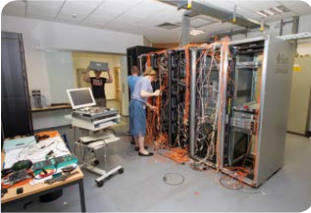
Ausbau aller Server
