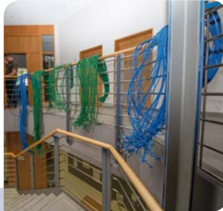
Vorbereitungen für die Neuverkabelung
